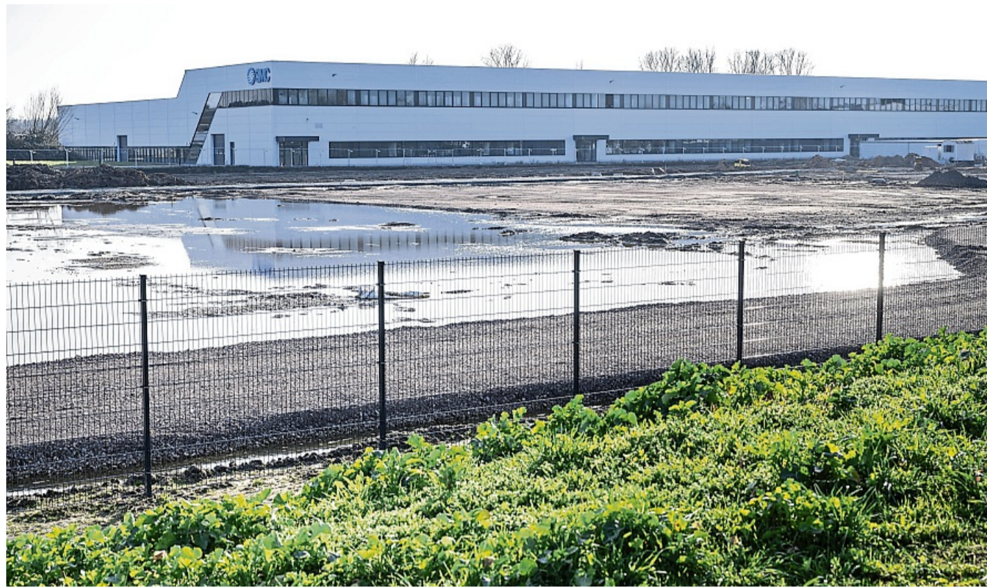
Auf mehr als 32.000 Quadratmetern lässt SMC fünf neue Gebäude entstehen. Die Vorbereitung des schlammigen Untergrundes – zuvor war dort Ackerfläche – erfordert hohen Aufwand.
